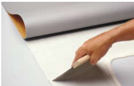
Lijm aanbrengen
