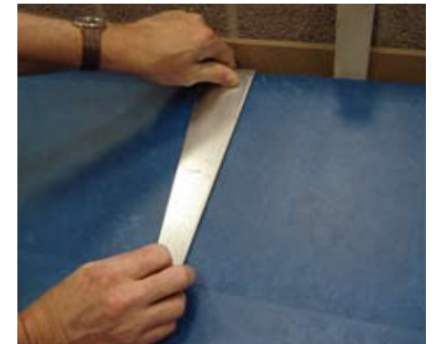
Paneel in de groef trekken met aanslagijzer
