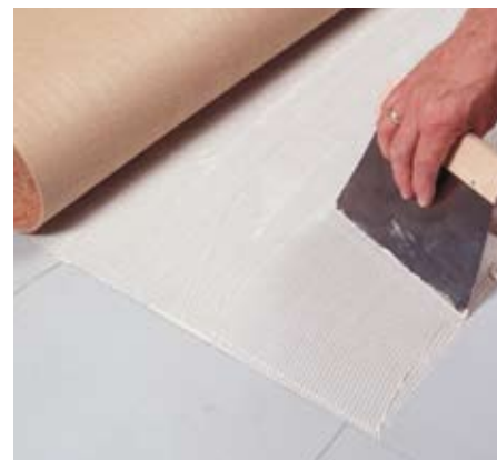
Lijm aanbrengen
