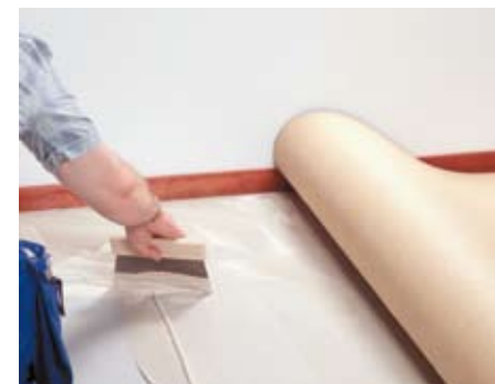
Lijm aanbrengen
