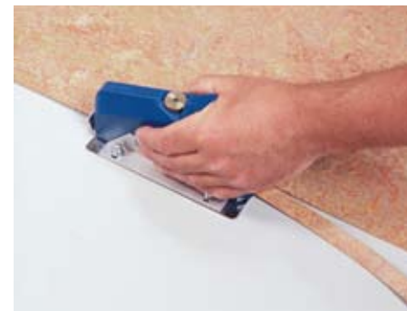
Fabriekskant verwijderen
