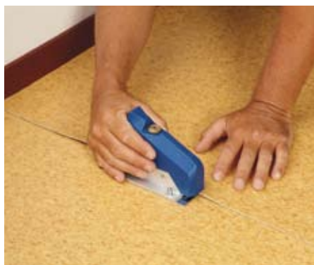
Fabriekskant verwijderen
