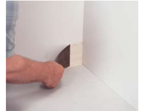
Lijmbed aanbrengen
