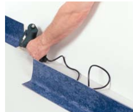
Smelthars aanbrengen
