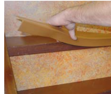
Aanbrengen trapkantprofiel
