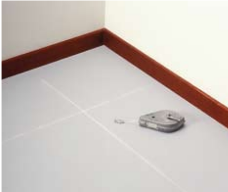
Plaats randpatroon bepalen m.b.v. spatlijn
