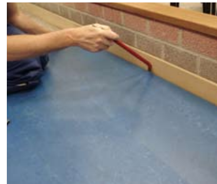
Paneel in de groef trekken met koevoet
