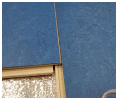
Kleine kier lengterichting
